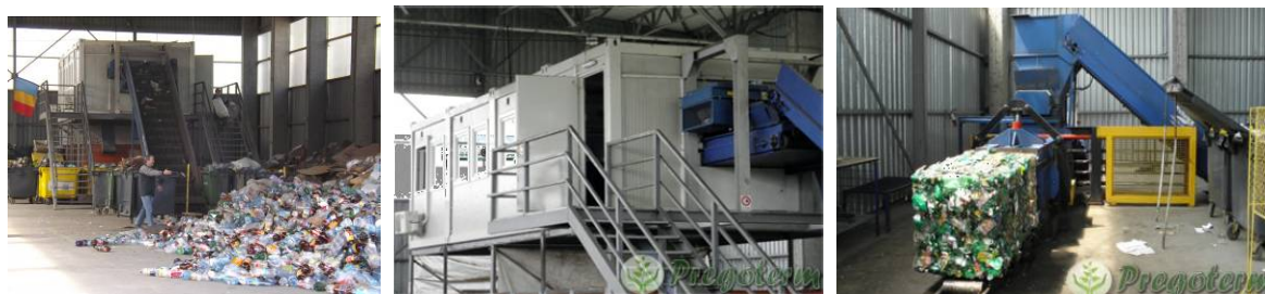
Fig. 4. Hală de primire a deșeurilor, instalația de sortare și cea de balotare PET-uri (***, 2018)
