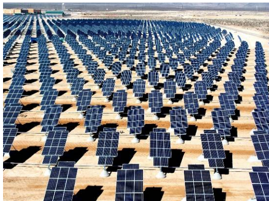
Fig. 2. Câmp cu panouri solare (Sursa: https://labo-energetic.eu , 2013)
