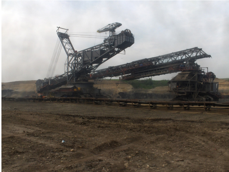
Fig. 8. Excavator cu rotor Esrc1400-30/7 și circuit de benzi transportoare de front
