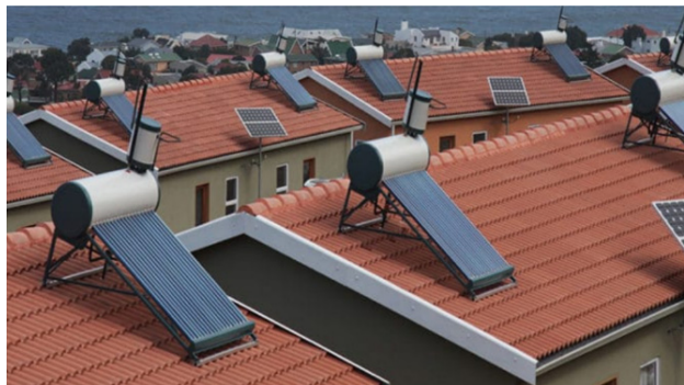
Fig. 6. Panouri solare pentru apă caldă
