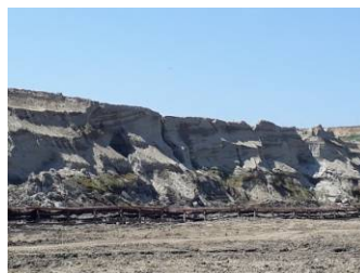
Fig. 4 Zone sufozionare pe treapta I a carierei
